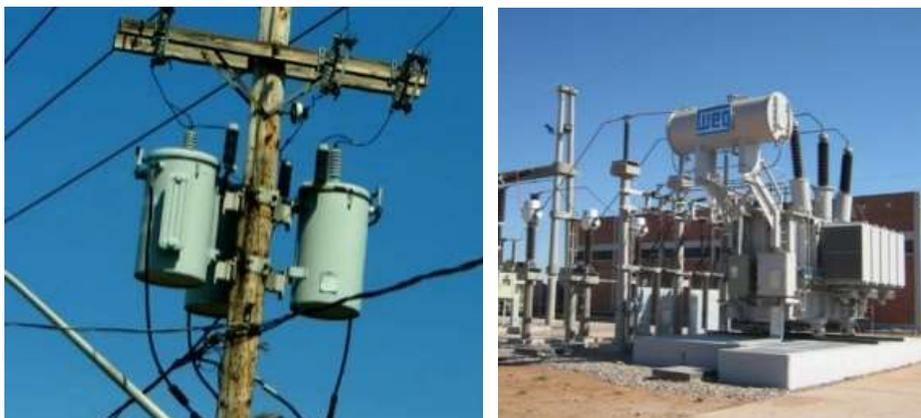
Ilustración 3 Equipos eléctricos que contienen aceite dieléctrico.
