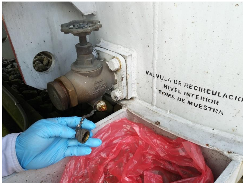
Ilustración 20 Muestreo de PCB en equipo con válvula para toma de muestras
