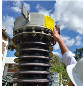
Ilustración 8 Etiquetado de equipos según resultados del análisis de PCB.
