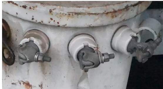
Ilustración 4 Bushing secundario
