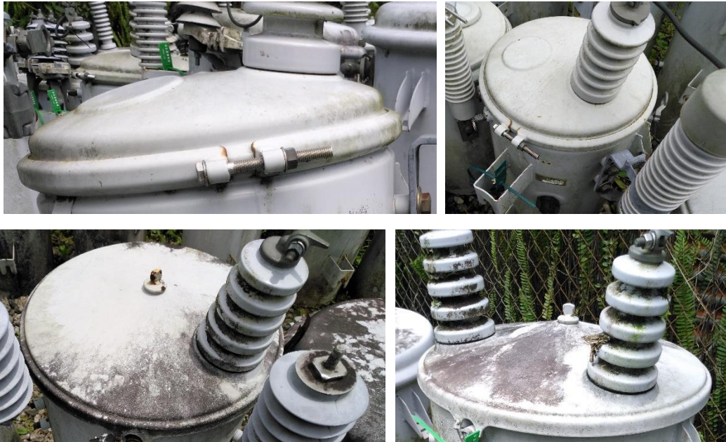
Ilustración 7 Detalle de sujetadores
