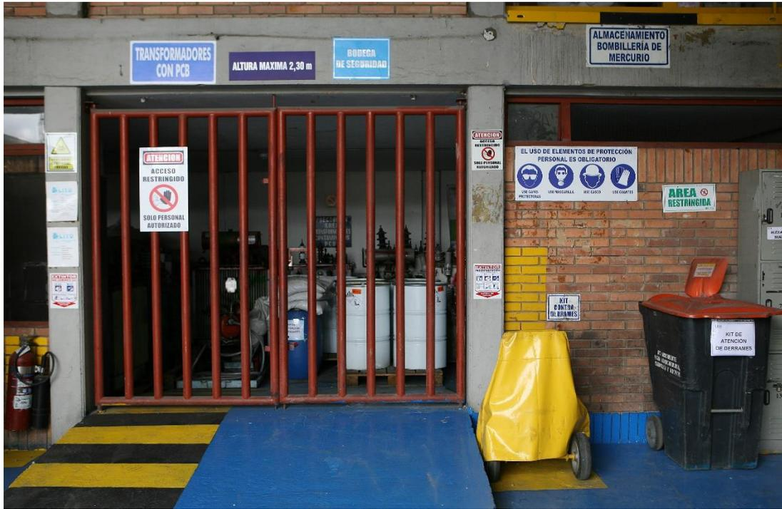
Ilustración 12 Área de almacenamiento de equipos con PCB, señalizado y con acceso restringido.
