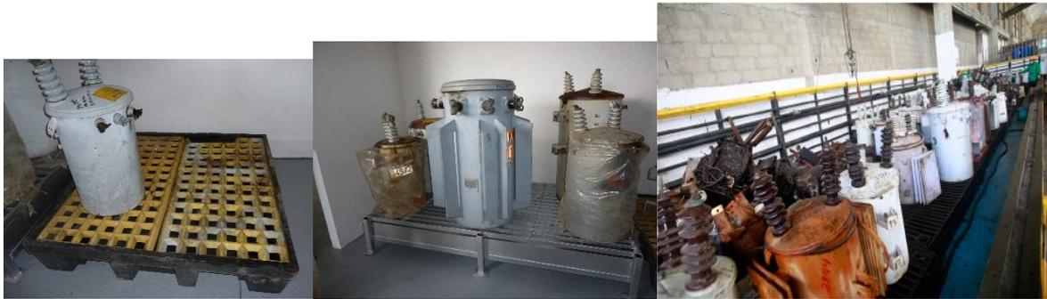
*Ilustración 9 Sistemas de contención de derrames.*
